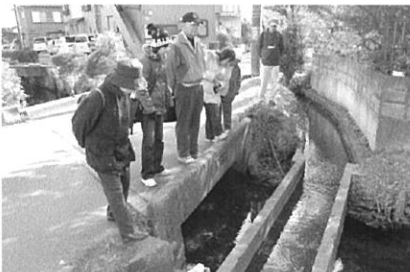
▲用水の立体交差の仕組みを視察
